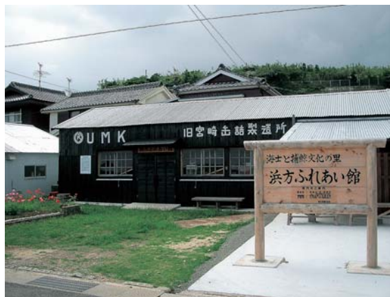
島民の手造り施設「浜方ふれあい館」
