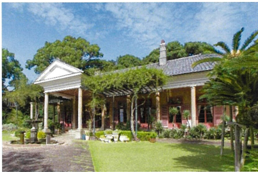
旧オルト住宅
